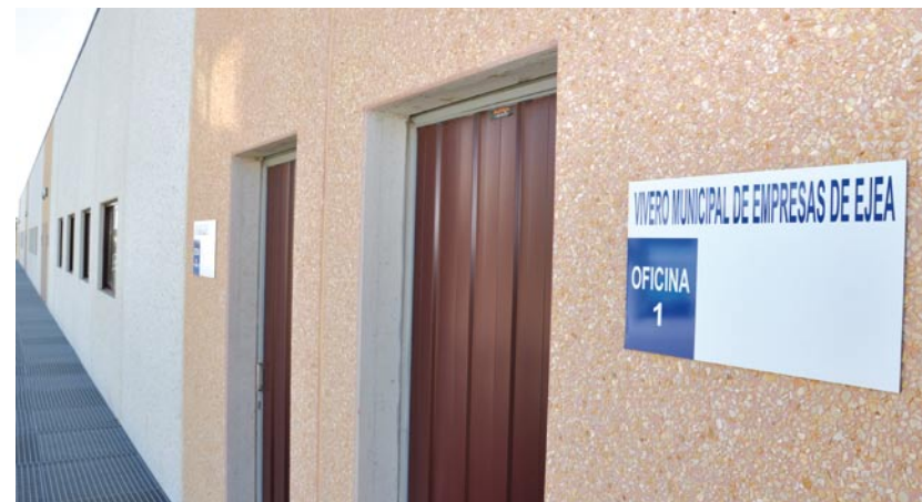
Acceso exterior a las oficinas.
