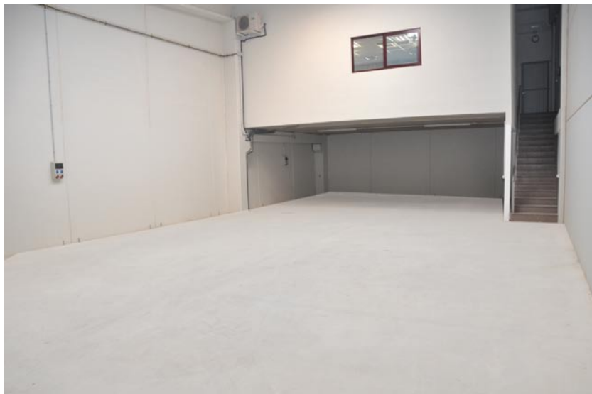
Interior de las naves.
